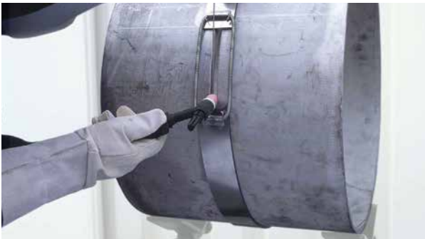
Abdichten des Schweißstosses während des Schweißens, Bild: E. Jankus
